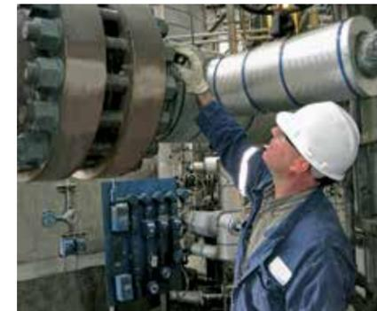
Verificación de torque: Los sujetadores inteligentes SPC4 permiten al instalador confirmar el torque para la instalación y el mantenimiento de rutina.
